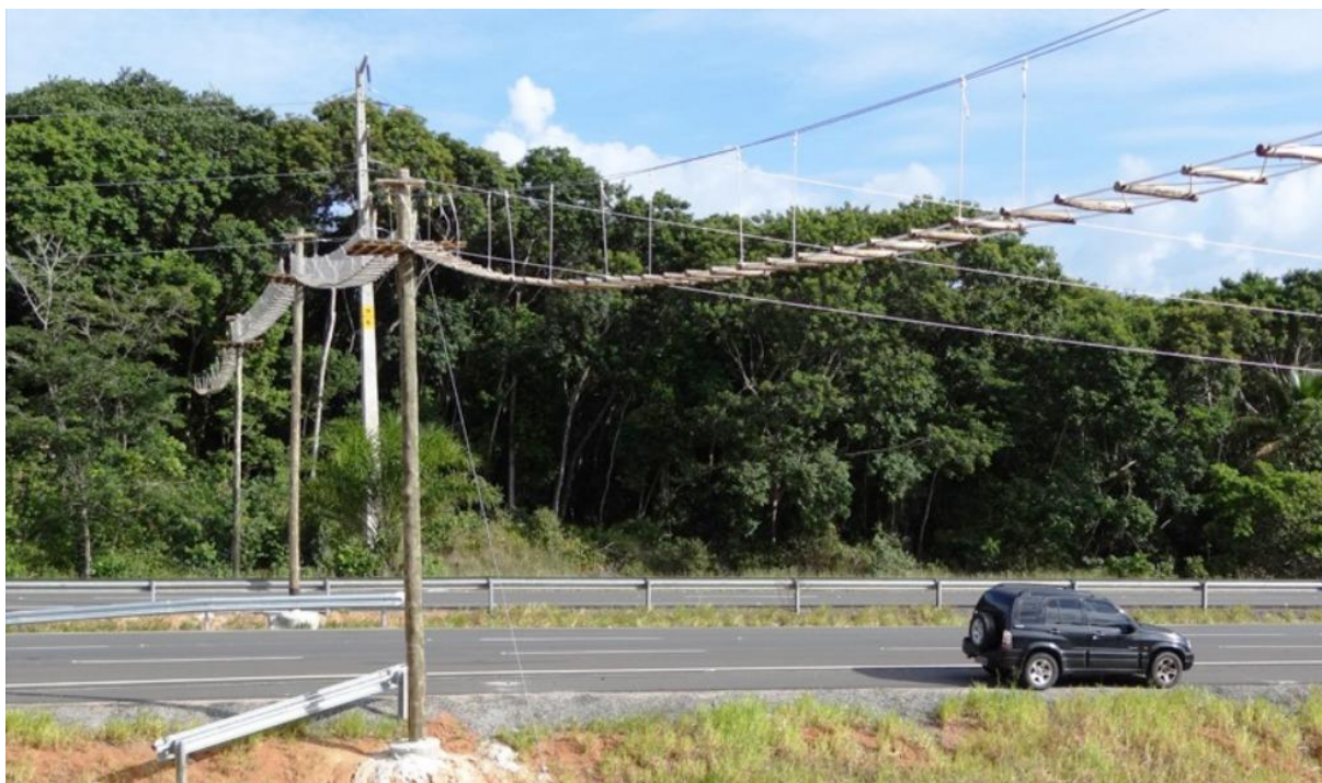
Figura 1 – Ilustração de modelo que pode ser utilizado para as passagens de fauna a serem instaladas pela contratada.
